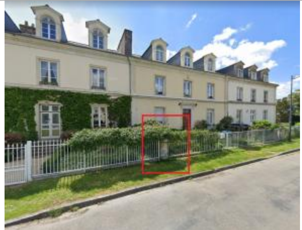
Poteau cloture entre les maisons du 4 et 6 quai de l'écluse
