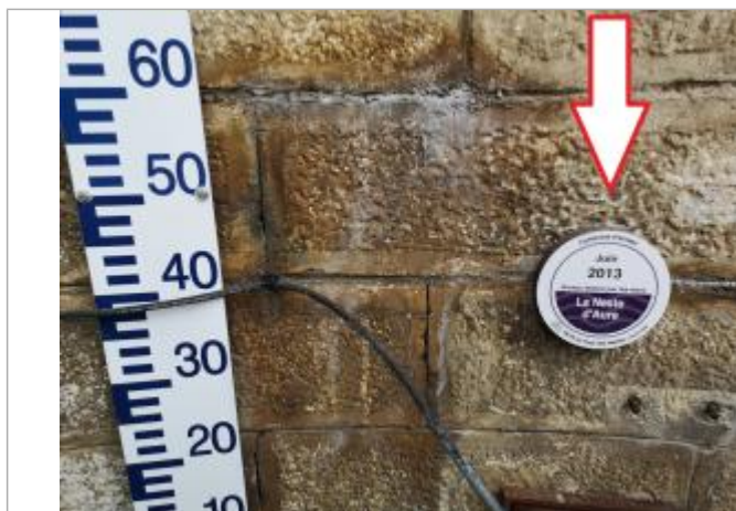
Vue rapprochée du repère, 2023. Auteur photo: AM Fromental
