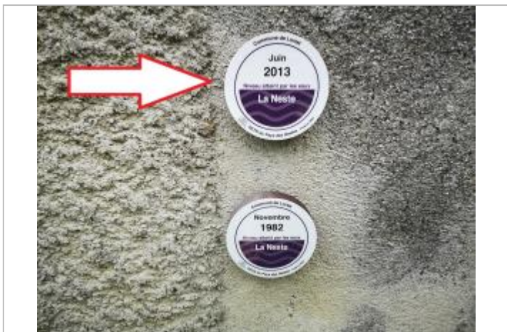
Vue rapprochée du repère, 2023. Auteur photo: AM Fromental.
