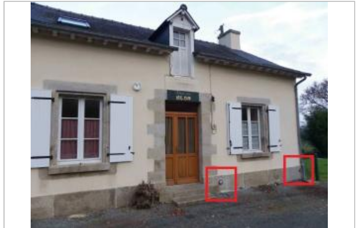
Maison éclusière de Blond à Guillac, repères crue et IGN
