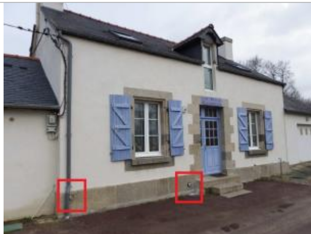
Maison éclusière de Carmenais à Guillac
