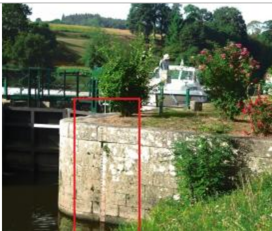
Aval de l'écluse de Carmenais à Guillac
