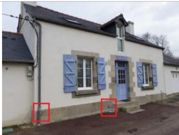
Maison éclésièrre de Carmenais à Guillac
