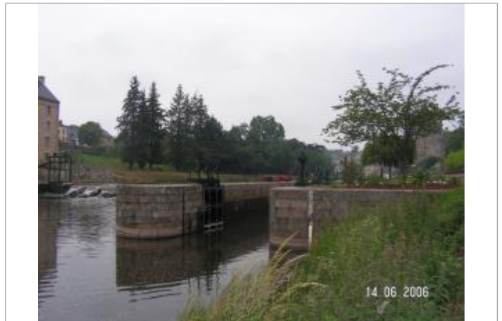
Ecluse de Josselin échelle aval
