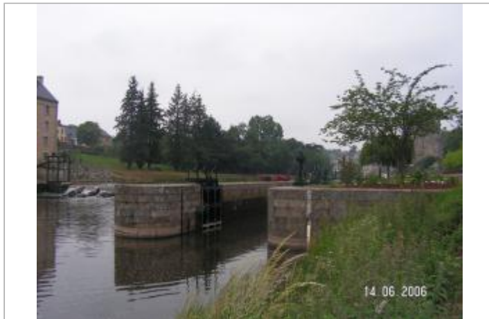
Ecluse de Josselin échelle aval
