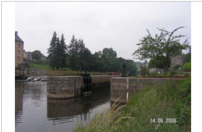
Ecluse de Josselin échelle aval
