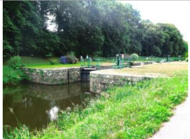
Ecluse de Beaufort échelle aval (disparue) à Josselin
