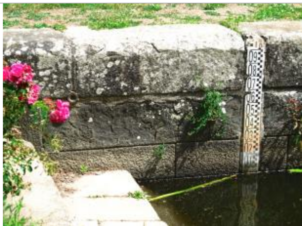
Ecluse de Beaufort échelle amont et repère IGN à Josselin
