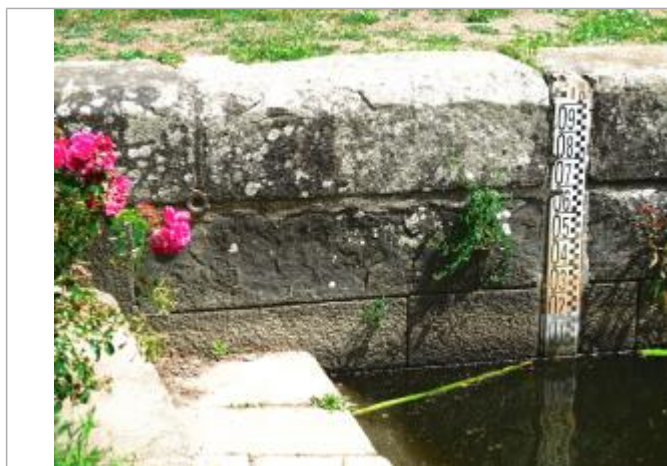
Ecluse de Beaufort échelle amont et repère IGN à Josselin
