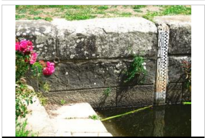
Ecluse de Beaufort échelle amont et repère IGN à Josselin
