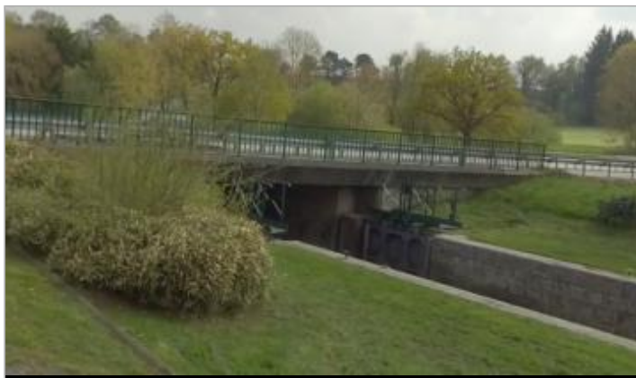
Ecluse de Caradec échelle aval (disparue) à les Forges de Lanouée
