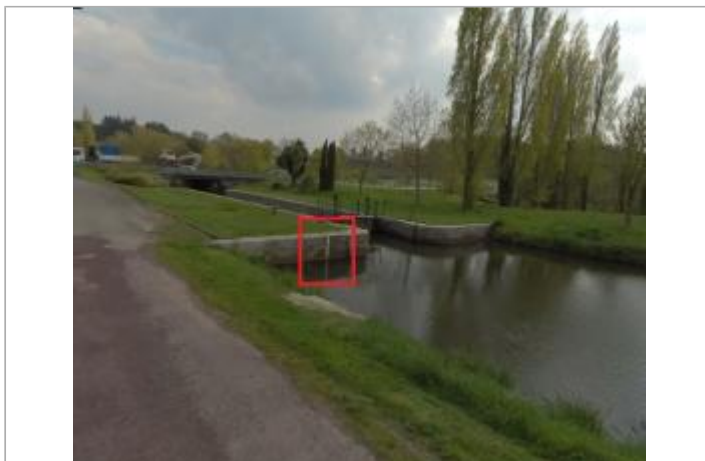
Ecluse de Caradec amont à les Forges de Lanouée
