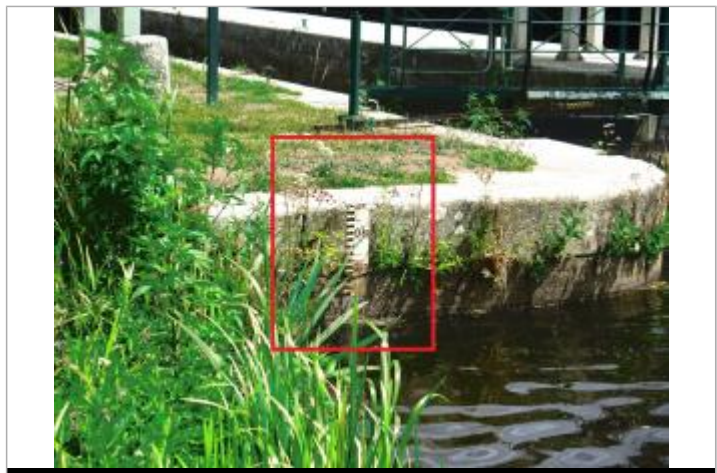
Ecluse de Rouvray échelle amont à les Forges de Lanouée
