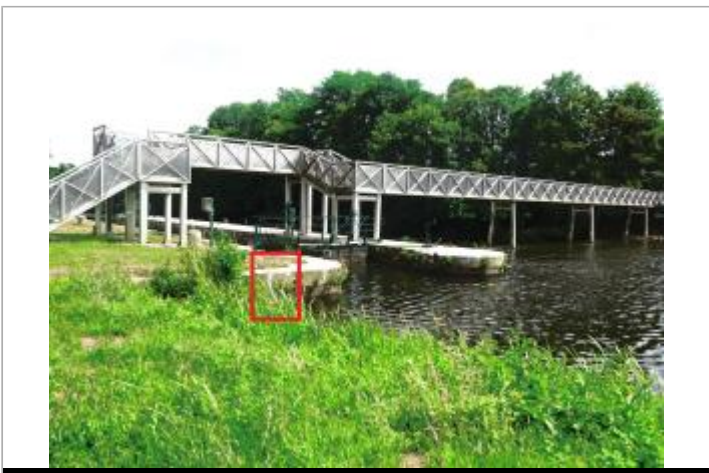
Ecluse de Rouvray amont à les Forges de Lanouée
