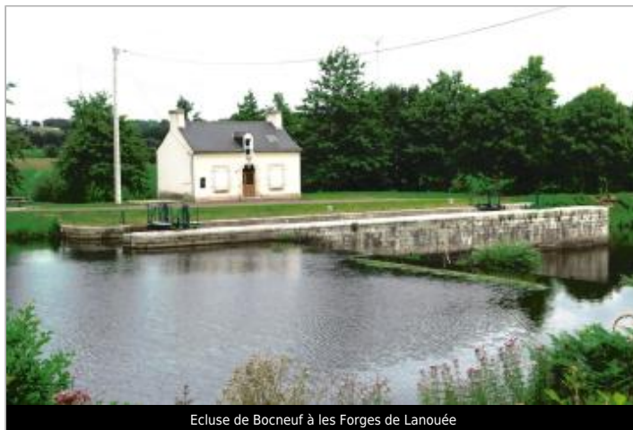
Ecluse de Bocneuf à les Forges de Lanouée
