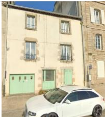
Immeuble au 13 quai Brizeux
