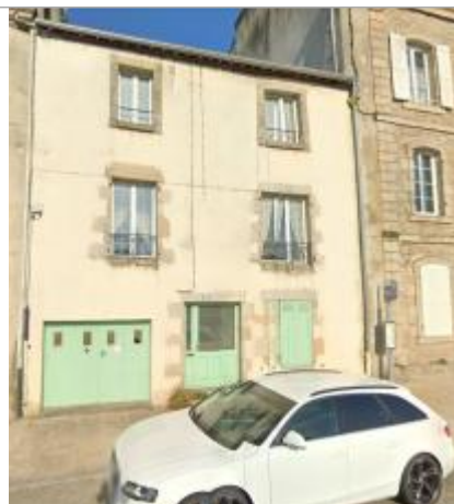
Immeuble au 13 quai Brizeux
