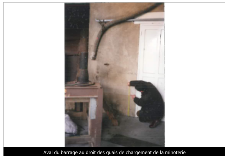
Aval du barrage au droit des quais de chargement de la minoterie
