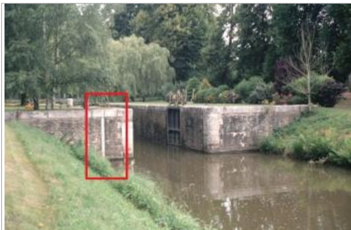
Ecluse de Pomeleuc aval à les Forges de Lanouée
