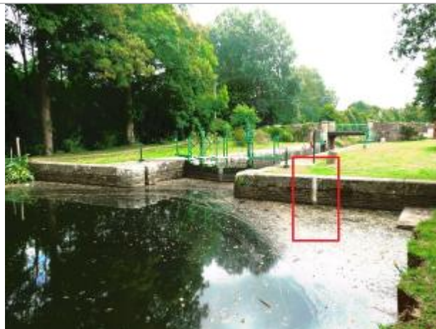
Ecluse de la Tertraie amont à Les Forges de Lanouée
