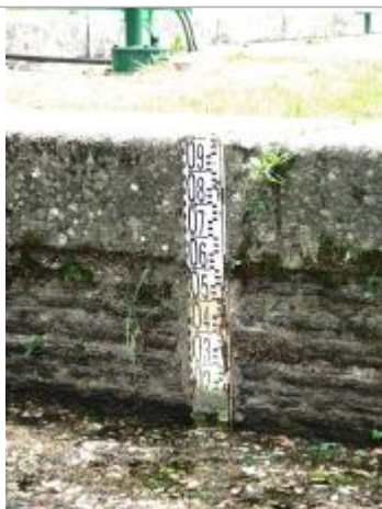
Ecluse de la Tertraie échelle amont à Les Forges de Lanouée
