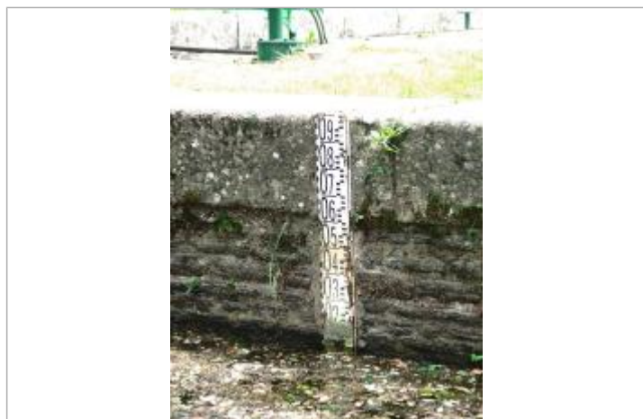
Ecluse de la Tertraie échelle amont à Les Forges de Lanouée
