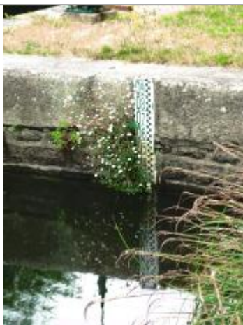
Ecluse de Cadoret à Pleugriffet échelle amont
