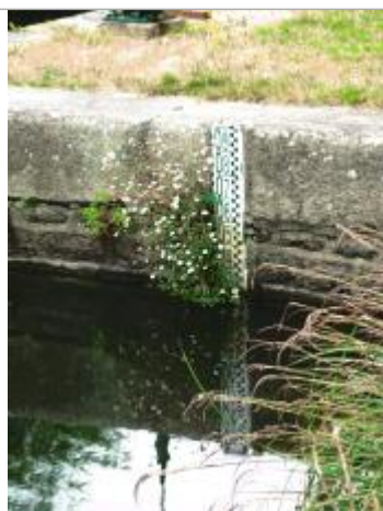
Ecluse de Cadoret à Pleugriffet échelle amont
