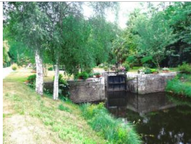
Ecluse du Lié aval à Pleugriffet
