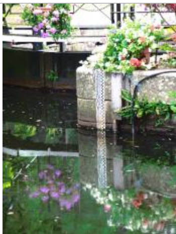
Ecluse du Lié à Bréhan échelle amont
