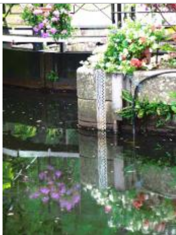
Ecluse du Lié à Bréhan échelle amont
