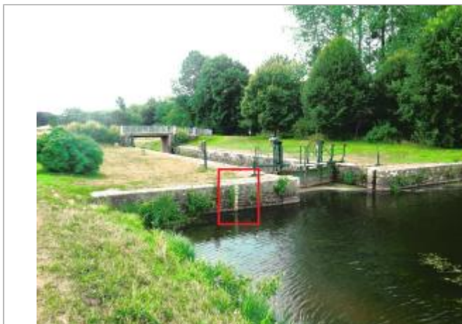
Ecluse de Griffet amont à Bréhan
