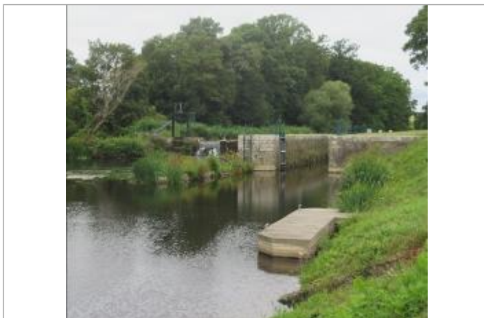
Ecluse de Grenoulliere aval à Bréhan
