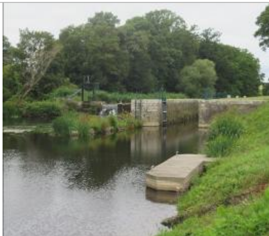
Ecluse de Grenoulliere aval à Bréhan
