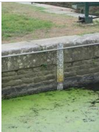
Ecluse de Grenouliere à Bréhan échelle amont
