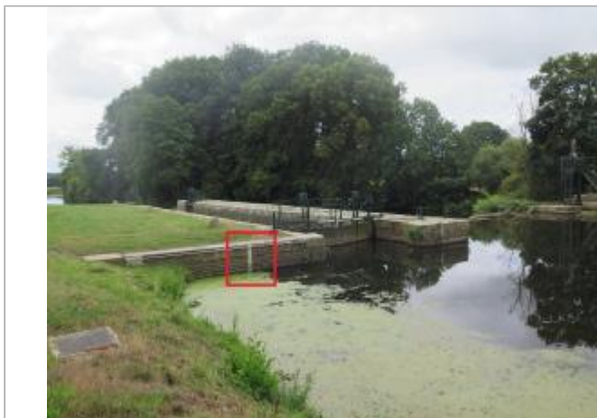
Ecluse de Grenouilliere amont à Bréhan
