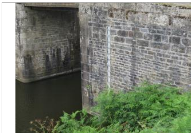
Ecluse de Trévérand à Bréhan échelle aval
