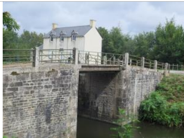
Ecluse de Trévérand à Bréhan aval
