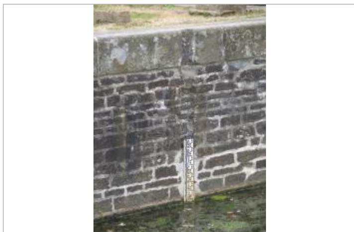
Ecluse de Timadeuc à Bréhan échelle amont
