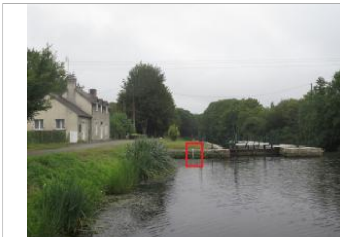
Ecluse de Quenjo amont à Rohan
