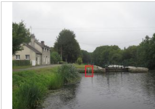
Ecluse de Quenjo amont à Rohan
