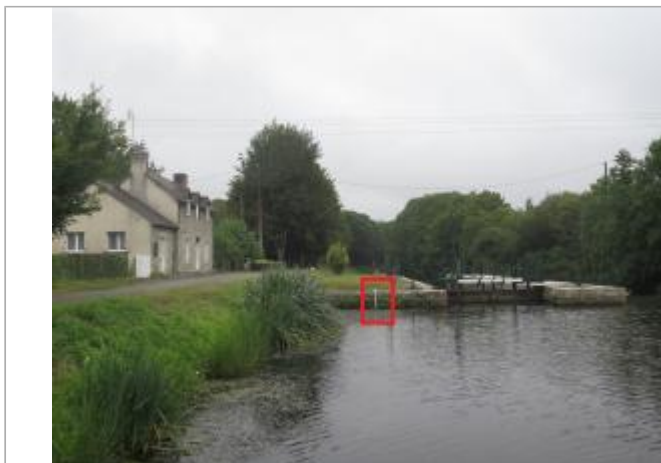
Ecluse de Quenjo amont à Rohan
