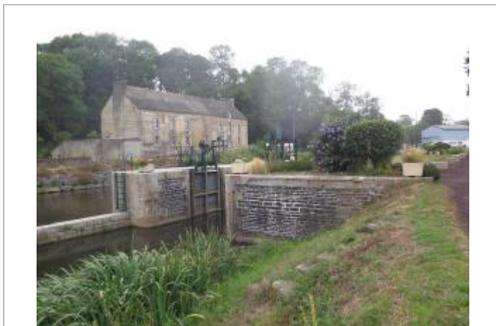
Ecluse de Rohan échelle aval (disparue)
