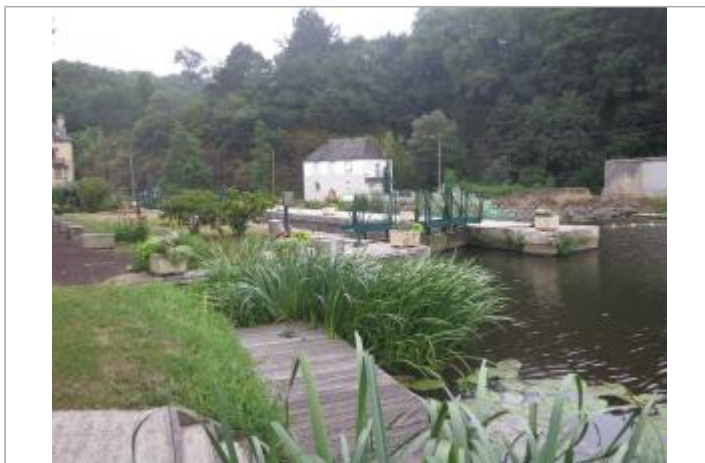
Ecluse de Rohan amont
