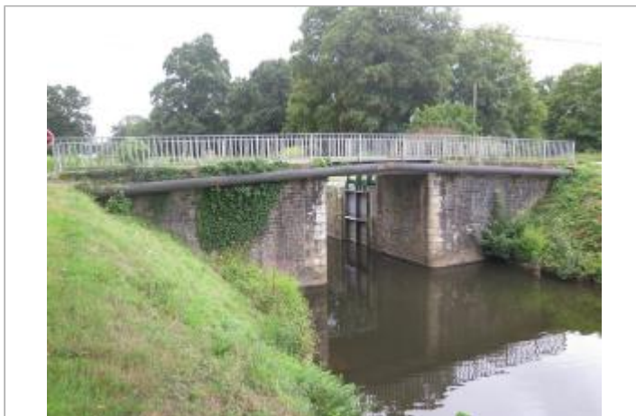
Ecluse de Saint Samson échelle aval (disparue)
