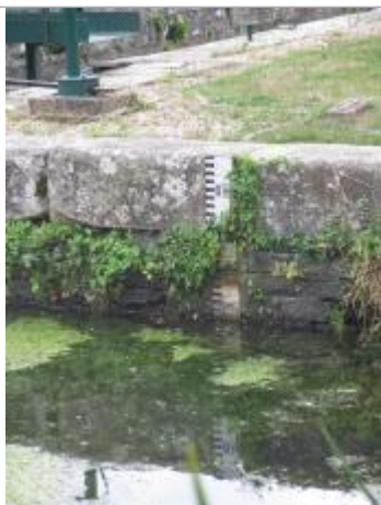
Ecluse de Saint-Samson échelle amont
