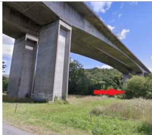
Piles du viaduc de la RN 165
