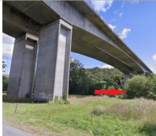
Piles du viaduc de la RN 165
