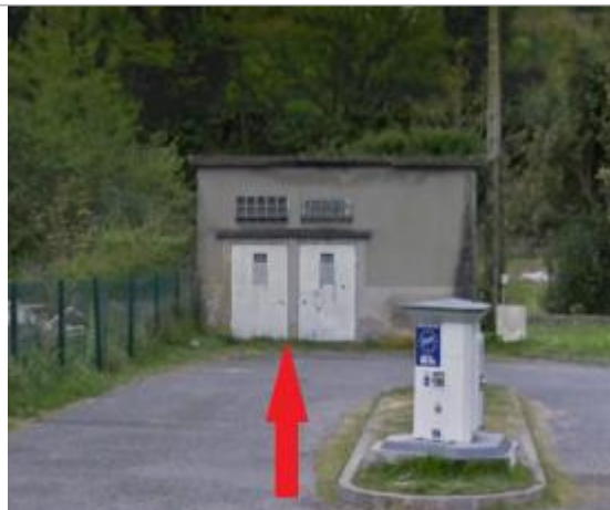
Transformateur à l'aire de camping-car
