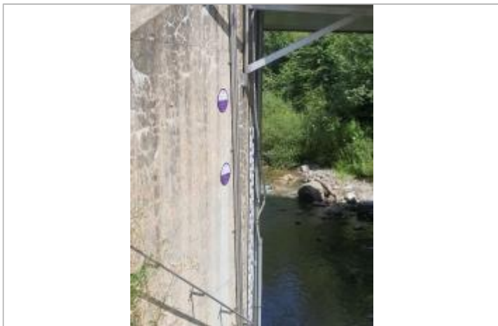
crue du Borne de 1997 (repère du bas)
