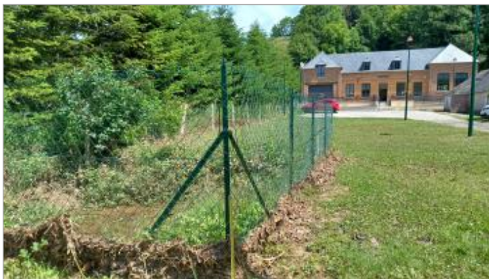
Laisse de crue sur grillage de clôture.
