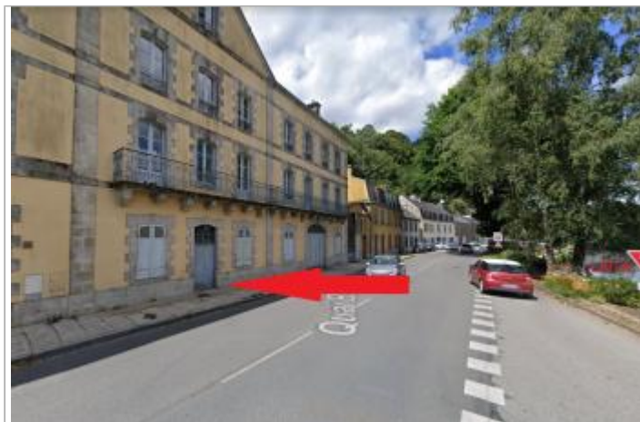
Maison au 22 quai Brizeux
