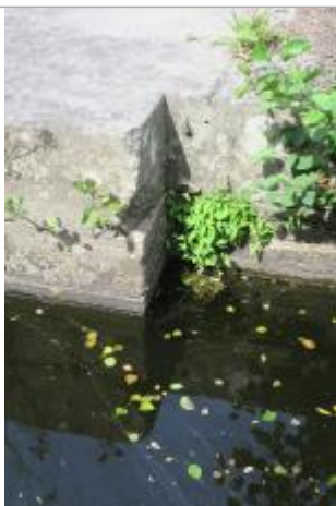
Ecluse de Bon-Repos échelle amont (disparue)
