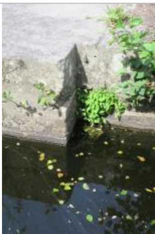
Ecluse de Bon-Repos échelle amont (disparue)
