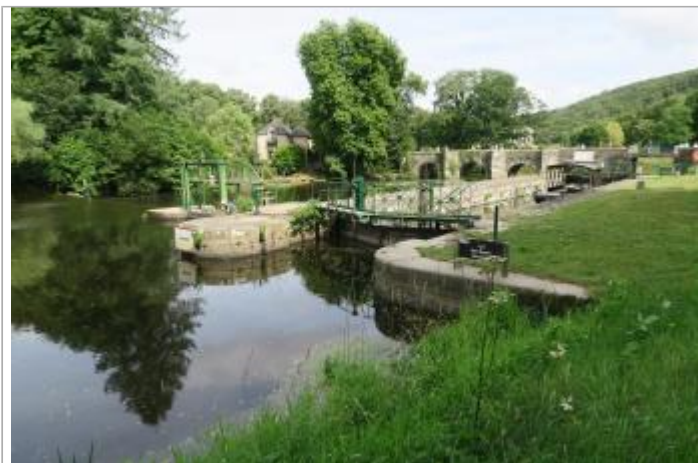
Ecluse de Bon-Repos échelle amont
