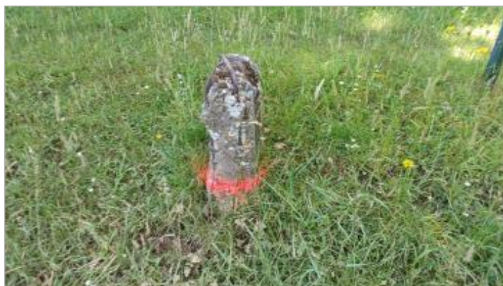
Laisse de crue à 21 cm/sol.
