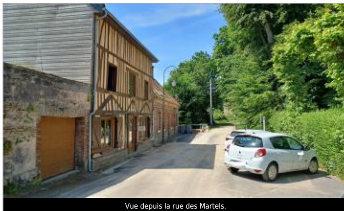
Vue depuis la rue des Martels.
