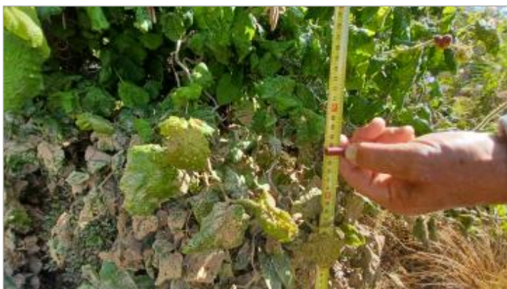
Laisse de crue à 65 cm/sol.
