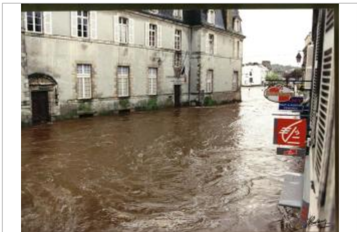
rue de la paix - inondation décembre 2000
