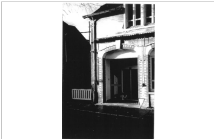
+1,20m Dalle béton devant porte du bureau d'accueil
